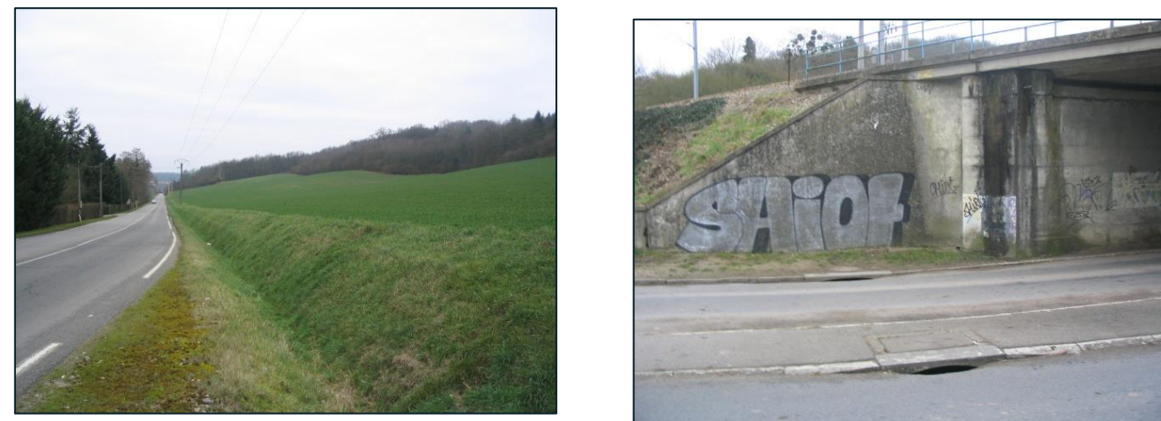
Figure 63 : Fossé sur la RD129 (à G.) et Avaloirs sur la RD55 à hauteur de Chenappeville (à D.)
