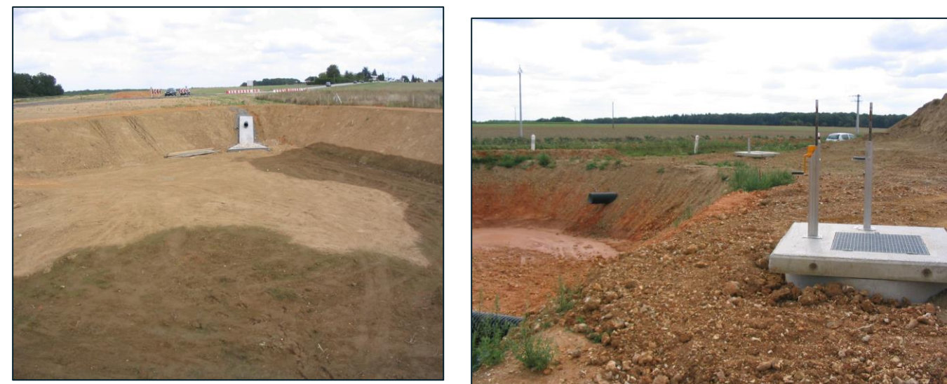
Figure 78 : Bassin en cours de réalisation (à G.) et système de vannage pour mise en service du bippasse (à D.)
